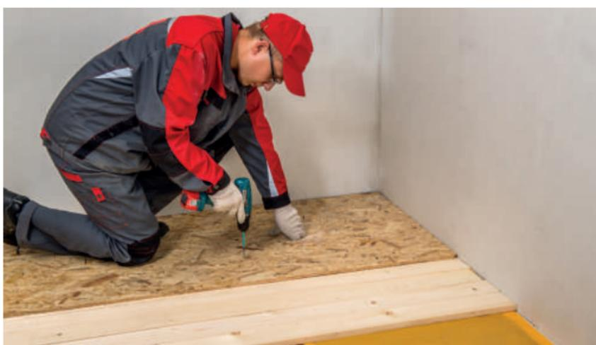
Рис. 4. Монтаж чернового пола
