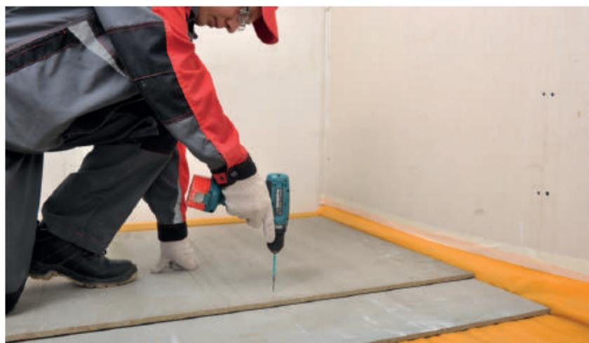
Рис. 9. Устройство сборной стяжки
