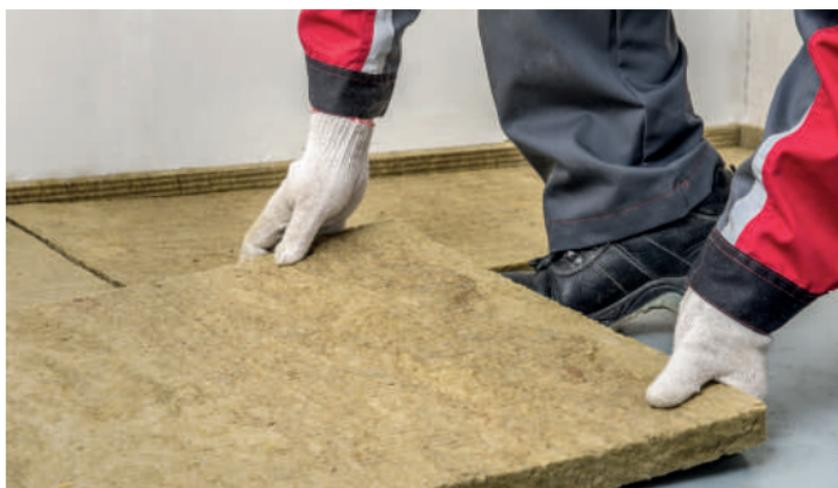
Рис. 7. Укладка плит ТЕХНОФЛОР СТАНДАРТ
