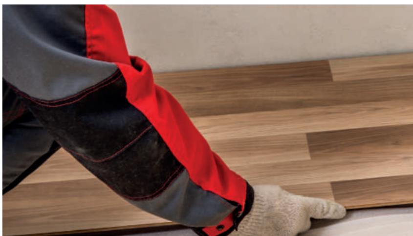
Рис. 13. Монтаж планок ламината
