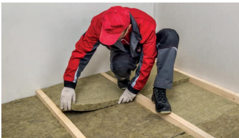
Рис. 2. Монтаж теплоизоляции враспор между лагами
