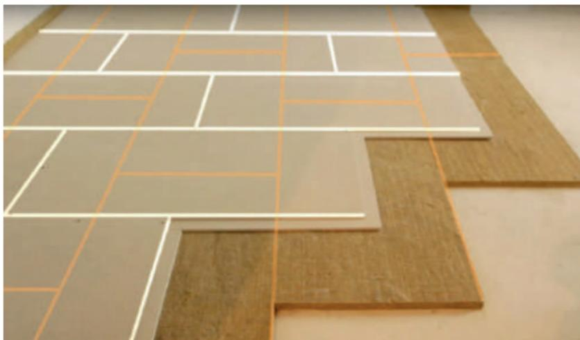
Рис. 10. Разбежка швов сухой стяжки и звукоизоляционных плит
