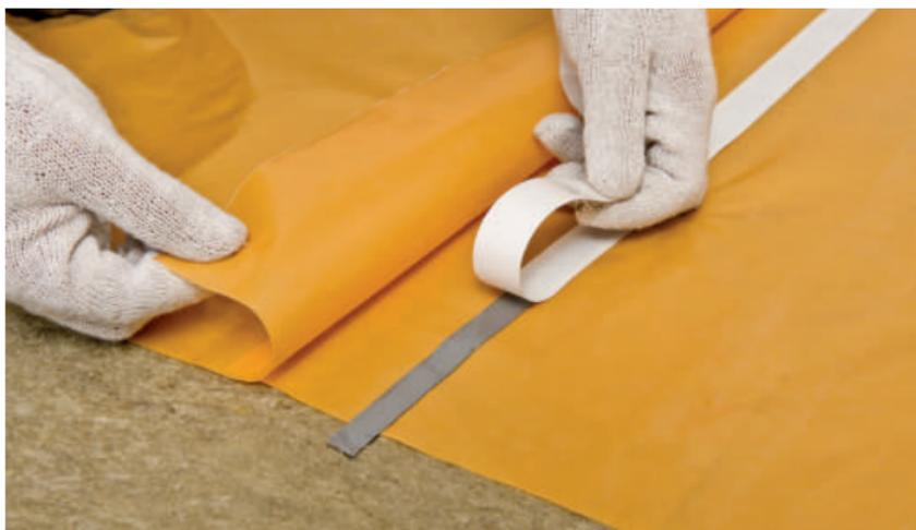
Рис. 3. Монтаж и проклейка нахлестов пароизоляционной пленки
