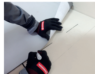
Рисунок 5.14. Защита зоны сварного шва от попадания клеевого состава
