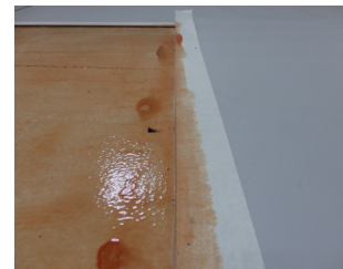
Рисунок 5.14. Защита зоны сварного шва от попадания клеевого состава
