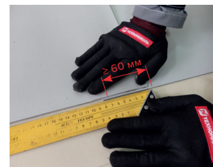
Рисунок 5.11. Варианты раскладка рулонов полимерных мембран
