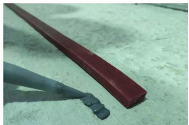
На подготовленную поверхность бетона нанесите герметик медленным, однообразным движением. Для этого выдавите достаточное количество герметика из тубы. Нанесение производить полосой без разрывов посередине шва бетонного элемента. Если бетонная поверхность имеет шероховатости, количество герметика должно быть достаточным, чтобы выровнять их.
