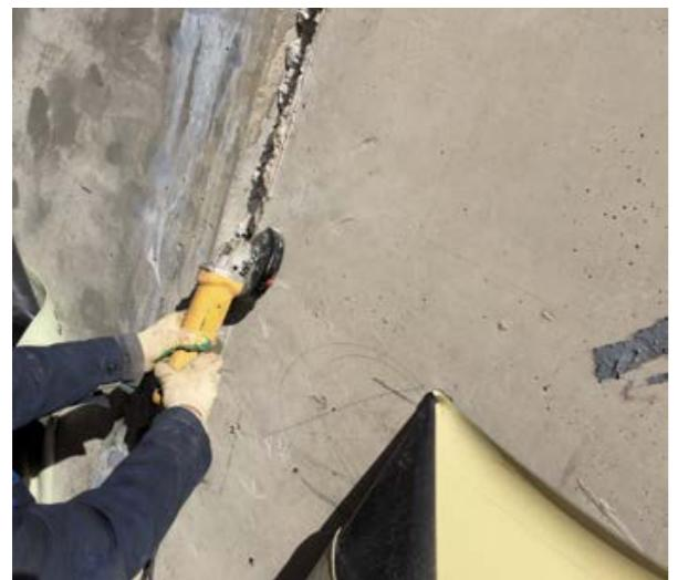
Бетонные и кирпичные основания и основания из натурального камня должны быть чистыми и прочными. Для удаления разрушающихся частей, следов краски, масел и цементного молочка необходимо произвести механическую обработку. Затем очистить поверхность от пыли при помощи сжатого воздуха.
