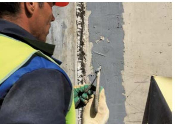
**ВАЖНО!** Наносите клей «с заходом» на Ленту **PVC LOGICBASE V-Strip** шириной около **20 мм**.
