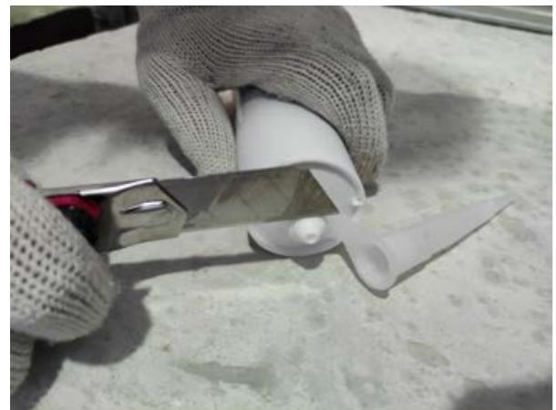
Срежьте пластиковый конус-наконечник на тубе. Установите носик и срежьте под углом для удобства нанесения герметика. Для увеличения наносимого слоя герметика сделайте больший срез носика.
