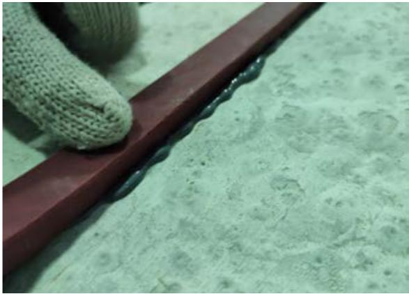
Уложите полимерный профиль поверх нанесенного в середине шва герметика. Зафиксируйте его плавным прижатием в свеженанесенный герметик. Минимальное расстояние от края шва до профиля должно быть не менее 8 см со всех сторон
