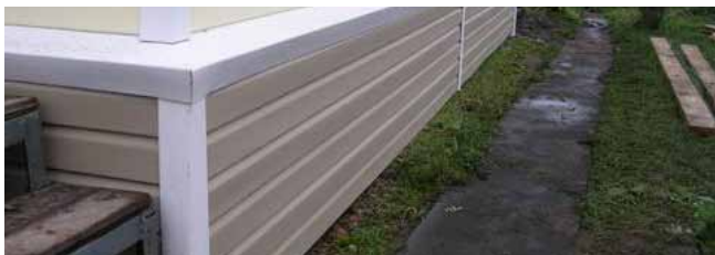
Отделка цоколя сайдингом
