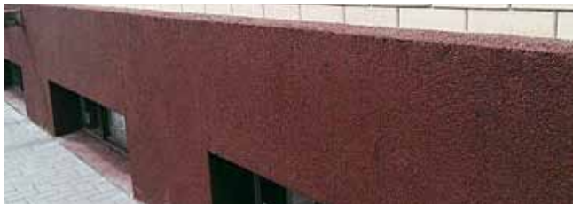
Отделка цоколя декоративной штукатуркой
