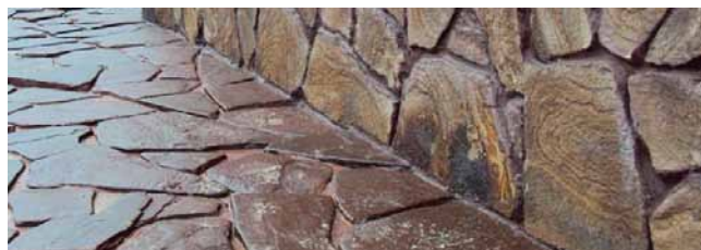
Отделка цоколя камнем
