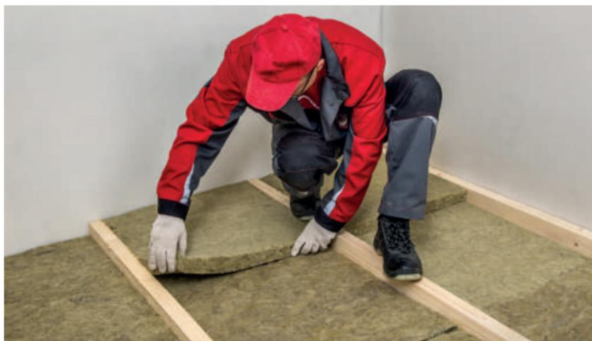
Рис. 2. Монтаж теплоизоляции враспор между лагами
