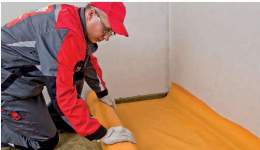
Рис. 8. Укладка гидроизоляции
