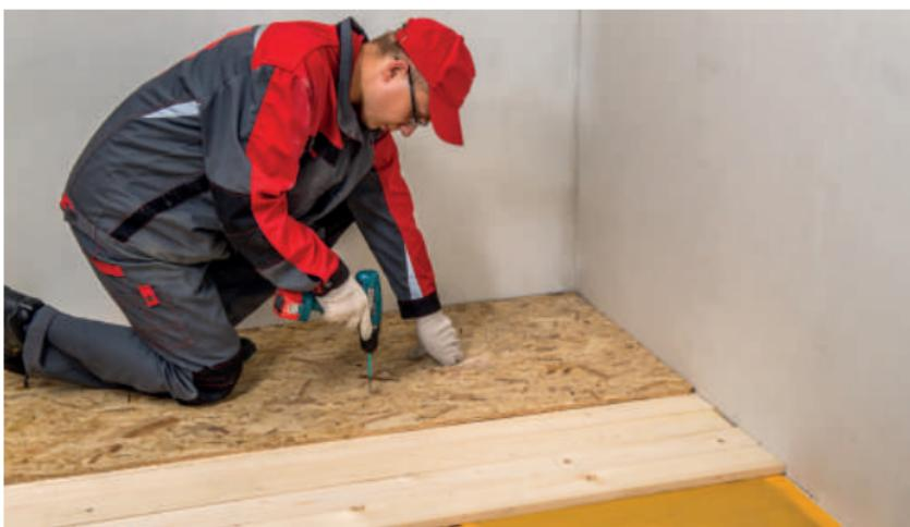
Рис. 4. Монтаж чернового пола
