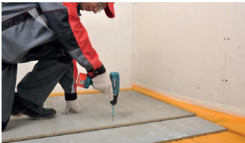
Рис. 9. Устройство сборной стяжки
