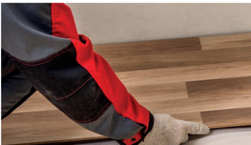
Рис. 13. Монтаж планок ламината
