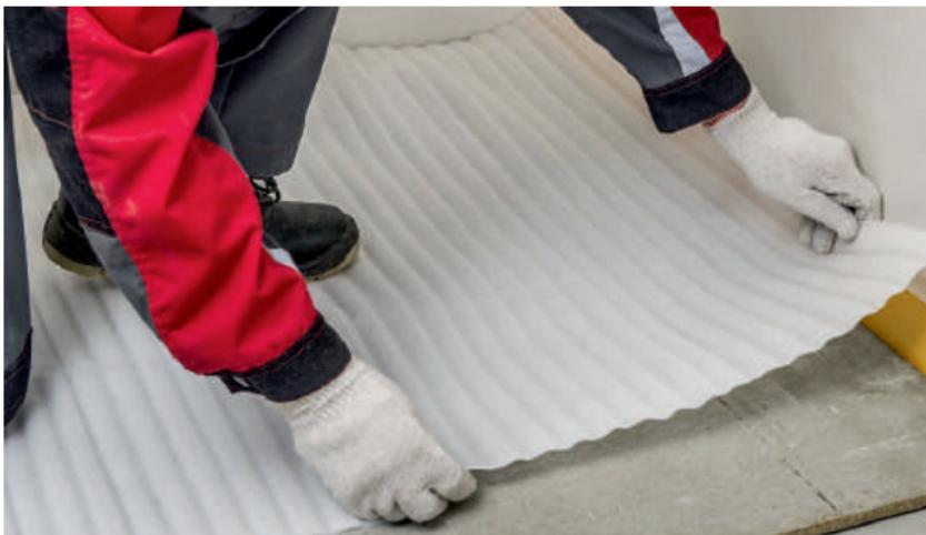
Рис. 12. Укладка подложки под финишное покрытие пола
