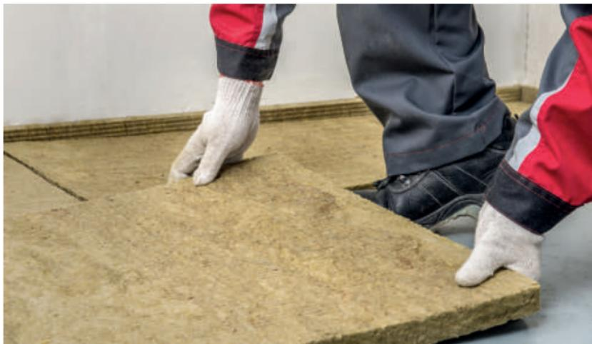
Рис. 7. Укладка плит ТЕХНОФЛОР СТАНДАРТ
