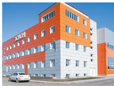
Завод «Эскон», г. Южноуральск
