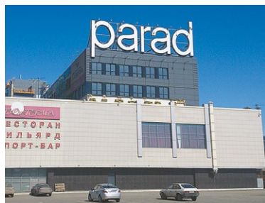
ТЦ «Parad», г. Барнаул
