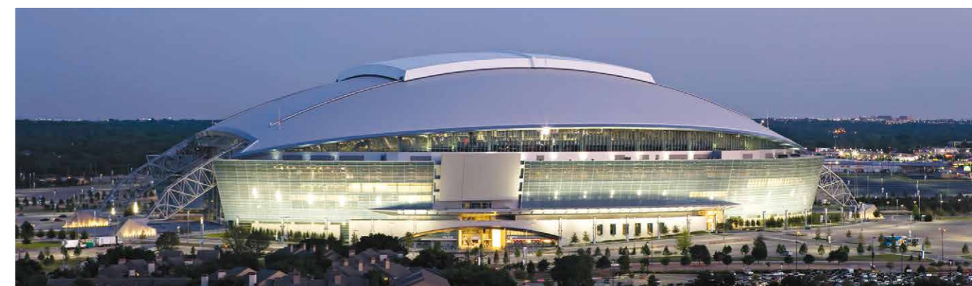
Cowboys Stadium Arlington, Texas, площадь кровли 55 800 м 2
