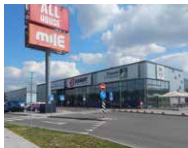
Строительный гипермаркет Mile, г. Минск
