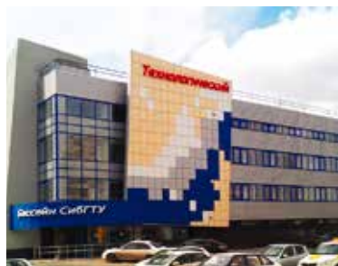
Бассейн SibGTU, г. Красноярск
