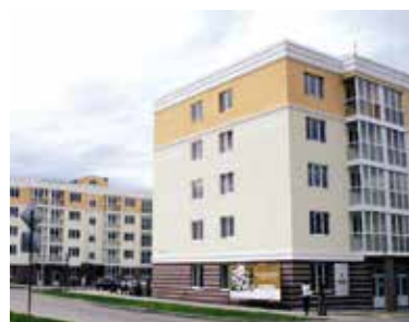
Жилой комплекс «Новый свет», г. Волгоград
