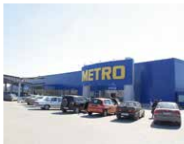
Торговый центр METRO, г. Пермь
