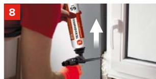
При заполнении вертикальных швов пену наносят снизу вверх. В швах с размерами более 50x40 мм, заполнение производится послойно, с увлажнением каждого слоя. Интервал между слоями 20 мин.
