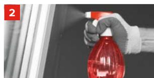
Обязательно увлажните поверхность водой для улучшения сцепления пены. Не наносите пену на поверхность нагретую выше +45 °С!
