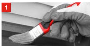
Очистите поверхность при помощи мягкой щетки или кисти. Для удаления жировых загрязнений используйте ветошь, смоченную очистителем монтажной пены ТЕХНОКОЛЬ.
