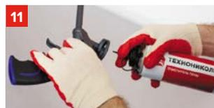
После завершения работ необходимо тщательно очистить пистолет с помощью очистителя монтажной пены ТЕХНОКОЛЬ.
