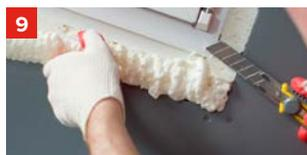
Процесс полной полимеризации пены составляет 24 часа. После этого удалите излишки пены и установите откосы.
