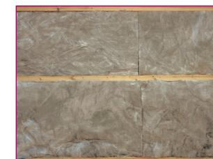
**4** Если толщины утепления недостаточно, то перпендикулярно стойками каркаса монтируются бруски для дополнительного контрутепления. Стекловолоконно ТЕХНИКОЛЬ Тёплый каркас устанавливаются враспор горизонтально.
