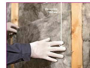
**3** При монтаже стекловолокна в несколько слоёв обязательно наличие перехлёста не менее, чем 150 мм. Благодаря гибкости и упругости плиты из минеральной изоляции на основе стекловолокна ТЕХНИКОЛЬ Тёплый каркас не требуют дополнительного крепления.
