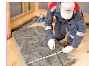
**2** Если расстояние между стойками каркаса меньше чем ширина плиты, то подрезаем минеральную изоляцию ТЕХНИКОЛЬ Тёплый каркас до необходимого размера. Нарезку осуществляем на жестком основании при помощи ножа для теплоизоляции или пилы с мелкими зубьями.
