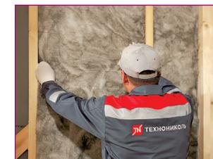
**1** Расстояние между стойками каркаса должно быть на 10-15 мм меньше чем ширина плиты. Утеплитель укладываем между стойками каркаса враспор с внутренней стороны помещения.
