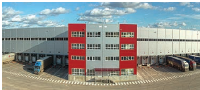
СКЛАДСКОЙ КОМПЛЕКС ЛОГОПАРК «СЕВЕР-2» СИСТЕМА ТН-КРОВЛЯ ГАРАНТ г. Москва Солнечногорский район, Московская область
