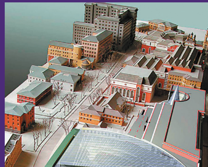
Музейный комплекс Государственной Третьяковской галереи 2013 – 2015 г. Москва, наб. Кадашевская, 10 Гидроизоляционные и монолитные работы 10 000 м 2 LOGICBASE V-SL 2,0 мм
