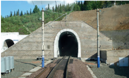
Джебский тоннель, Красноярский край
