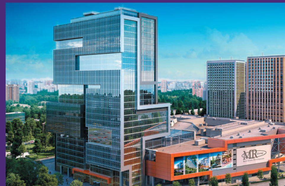
МФК ТЦ «Водный» 2013 – 2015 г. Москва, Головинское шоссе, 5 Гидроизоляция фундамента и стилобата Площадь 55 000 м 2 LOGICBASE V-SL 2,0 мм и LOGICBASE V-ST 1,6 мм
