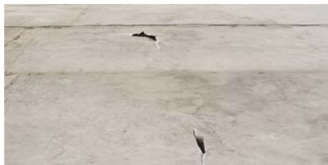
Последствия волочения тяжелых предметов.
