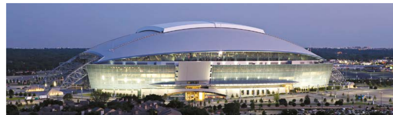
Cowboys Stadium Arlington, Texas, площадь кровли 55 800 м 2
