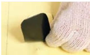
После проверки герметичности шва извлеките иглу из проверочного канала. На место прокола мембраны установите заплатку.
