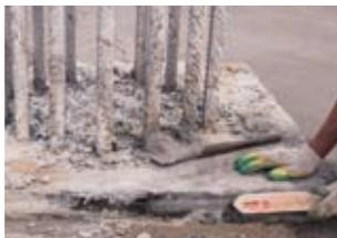
Уложите подстилающий слой геотекстиля на поверхность бетонной подготовки. Край геотекстиля не должен попадать на поверхность шпонки.
