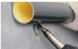
Сварите между собой полотна гидроизоляционной мембраны автоматическим сварочным аппаратом.
