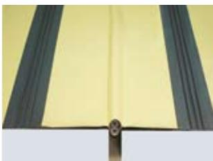
Установите контрольно-инъекционные штуцеры в образовавшуюся карту на расстоянии не менее **200 мм** от шпонки. Смещение оси смежных штуцеров относительно друг друга не менее **2000 мм**.
