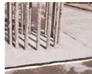
Примыкание гидроизоляционной мембраны к сваям может быть выполнено при помощи клеевой шпонки. В этом случае в опалубку гидрошпонка не устанавливается. После отливки оголовка вокруг сваи и снятия опалубки ПВХ ленту ТЕХНОНИКОЛЬ следует приклеить на поверхность гидробетона при помощи эпоксидного клея ТехноНИКОЛЬ. Мембрана приваривается к клеевой шпонке аналогично тому, как это было описано в предыдущем разделе.
