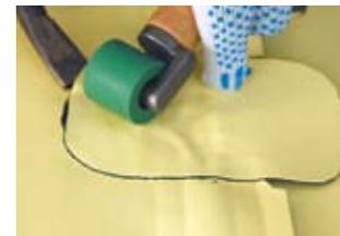
Заварите проверочный канал с противоположного «конца» шва и установите заплатку. После произведите проверку давлением воздуха.
