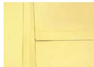
Усильте все Т-образные пересечения мембран, установив заплатки. Для этого вырежьте заготовку размером **120×120 мм** из мембраны **LOGICBASE V-SL**.
