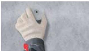
Механически зафиксируйте рондели через геотекстиль на поверхности стены.
