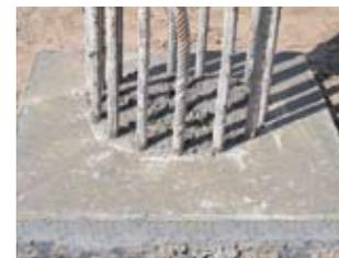
После твердения гидробетона, демонтируйте опалубку.
