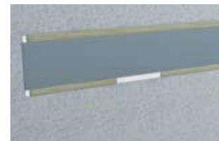
Установите вторую ленту на уже установленную с нахлестом минимум **10 см**. Уделите особое внимание качеству приклейки в том месте, где на край нижней ленты не был нанесен клей. Разметьте и отрежьте сформированный нахлест, как показано на рисунке.
