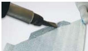
Удалите оплавленный флис металлической щеткой, это позволит повысить надежность соединений.
