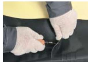
На участке шва, где был срезан свободный край, следует снять фаску, чтобы сформировать плавный переход и избежать в этом месте «ступеньки», которую будет сложно проварить.
