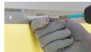
Шаг установки саморезов **200 мм**.
