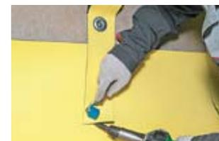
При монтаже следующего ряда мембраны обеспечьте нахлест между нижним и верхним рядами мембраны не менее **100 мм**.
