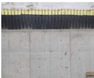
**ВАЖНО!** Не допускайте попадания защитной стяжки на ребра гидрошпонок. Для этого необходимо при укладке полиэтиленовой пленки сначала закрыть всю гидроизоляцию, включая гидрошпонки, а после укладки защитной стяжки полиэтиленовую пленку над шпонкой срезать.
