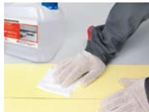
Выполняйте сварочные работы только на чистых и сухих поверхностях мембраны. Удалите со свариваемых поверхностей грязь и пыль при помощи влажной ткани, смоченной очистителем составом для ПВХ мембран **ТехноНИКОЛЬ**.
