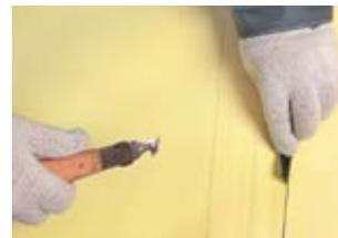
Свободный край срезается крючкообразным или макетным ножом на протяжении **120–140 мм**.
