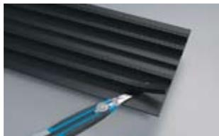
На одной из соединяемых шпонок срежьте анкерные ребра на ширину не менее **6–8 см**.
