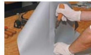
Вырежьте отверстие соответствующего диаметра.
