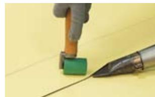
После того как полоса усиления установлена, приступайте к монтажу гидрошпонок **EC-220-3**.
