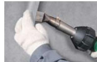
Скрепите точно нахлесты геотекстиля ручным сварочным аппаратом «Leister» модели «Triac PID» или «Triac S».
