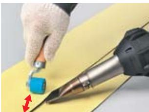
**ВАЖНО!** Сварка шва ручным оборудованием в три этапа распространяется на устройство всех швов, выполненных вручную.
