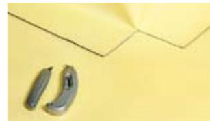
Приварите нахлест к горизонтально уложенной мембране вдоль направления угла.
