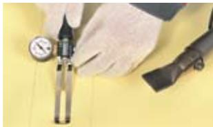
**ВАЖНО!** Будьте предельно осторожны при вводе иглы, она не должна повредить обратную сторону воздушного канала.
