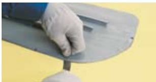
Завальцуйте край гидрошпонки на всем протяжении, где была снята фаска.
