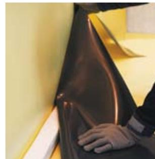
Приварите полосу усиления таким образом, чтобы она точно повторяла контур уложенного компенсатора.
