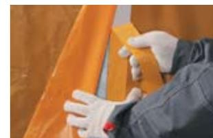
Скрепление нахлестов пленки также можно выполнить ручным феном в режиме низкой температуры.
