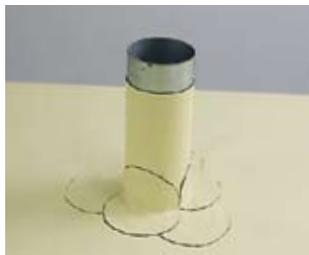
Для этого установите червячный хомут соответствующего диаметра, который должен надежно фиксировать мембрану на трубе.
