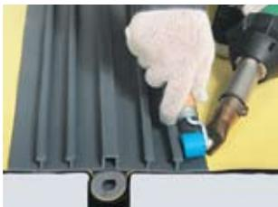
После сварки гидрошпонки и мембраны продолжайте монтаж остальных слоев пирога.
