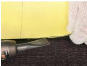
После выполнения сварки двух полотнищ мембраны шов следует запечатать с двух концов. Для этого запаяйте оба конца ручным сварочным аппаратом с прокаткой краёв тефлоновым роликом или зажмите их специальным зажимом.
