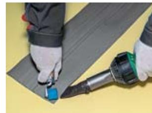
Насадку шириной **40 мм** поместите между свариваемыми поверхностями мембраны и гидрошпонки.
