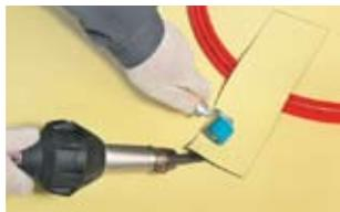
Для удобства монтажа трубок закрепите их на поверхности мембраны небольшим «хлястиком» мембраны.
