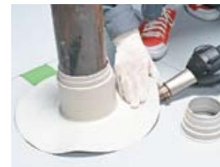
Снимите фаску с краев заплатки на ширину сварного шва (не менее **30 мм**).
