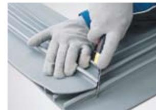
**ВАЖНО!** Не разрезайте плоскую часть гидрошпонки, а только ее ребра.
