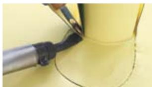
**ВАЖНО! Используйте латунный ролик для сварки в основании.**
