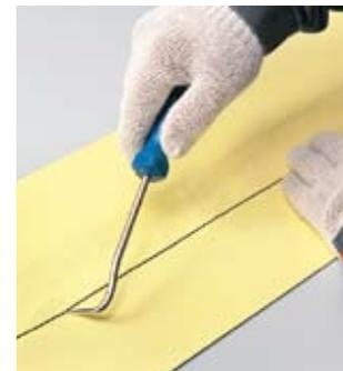
Для этого Вам необходимо воспользоваться пробником проверки качества шва или тонкой шлицевой отверткой (со скругленными краями шлица).
