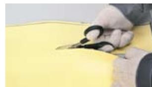
Закруглите уголок заготовки, который будет располагаться в вертикальном углу. С помощью ручного фена прогрейте и растяните закругленный уголок заготовки.
