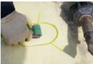
При механическом точечном повреждении гидроизоляции, ее восстановление следует производить наложением заплат размером не менее 120 мм в диаметре. При этом расстояние по всем направлениям от места повреждения до края заплат должно быть не менее 50 мм.
