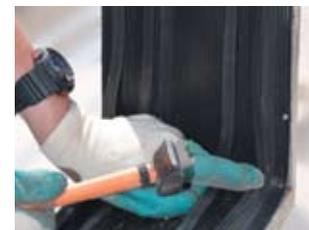
Установите заранее подготовленную опалубку с установленной гидрошпонкой вокруг оголовка сваи и заполните ее безусадочным гидробетоном с маркой по водонепроницаемости не менее **W 12**.
