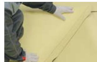
Приварите полосы во всех углах с заходом на горизонтальную поверхность.
