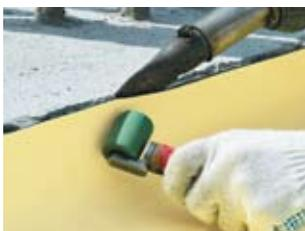
В местах раскроя материала на углах оголовка сваи установите усиливающие элементы в виде заплаток.
