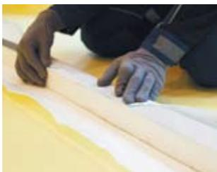
Для крепления геотекстиля или пленки используйте двусторонний скотч. При использовании вилатерма в качестве компенсатора оборачивать его не нужно.
