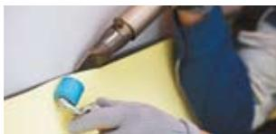
**ТЕХНОНИКОЛЬ** (см. п. 3.2 настоящего раздела). После того как лента установлена на поверхности бетона, герметично приварите мембрану **LOGICBASE V-SL** к ее поверхности.
