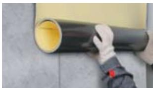
Обеспечьте не менее чем **100 мм** нахлест соседних полотен друг на друга. Сварите полотна мембраны между собой автоматическим сварочным аппаратом.
