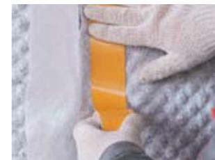
Скрепление нахлестов геотекстиля также можно выполнить ручным феном в режиме низкой температуры.
