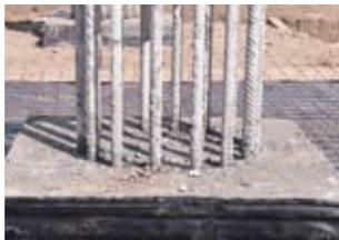
**ВАЖНО!** Обязательно очистите поверхность гидрошпонки от раствора после укладки бетонной подготовки.
