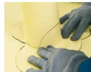
Приварите подготовленные заготовки, используя латунный прикаточный ролик, начиная от основания трубы и двигаясь к краям.
