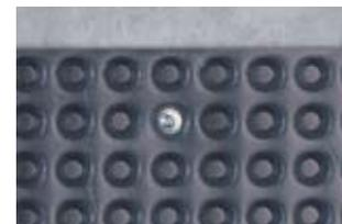
**Другой способ фиксации дренажного полотна – это крепление при помощи полос, вырезанных из ПВХ мембраны.**
