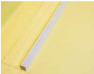
Для этого подготовьте брусок из экструзионного пенополистирола размером **50x50 мм**.
