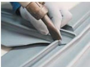
Поместите сопло в область стыковки двух ребер, дождитесь равномерного оплавления краев **2–4 сек.**, уберите насадку и зафиксируйте края ребер, плотно прижимая их друг другу.
