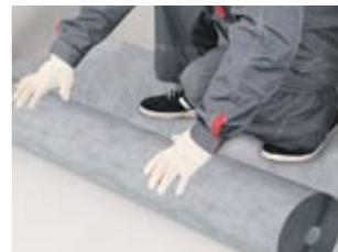
Во избежание расхождения полотен точно скрепляйте нахлесты горячим воздухом при помощи ручного сварочного фена.
