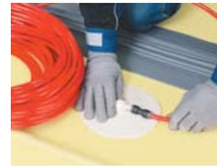
При помощи соединительных фитингов подсоедините инъекционные трубки к штуцерам.
