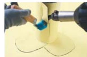
После того как «лепестки» приварены к основной мембране, сварите образовавшийся нахлест на трубе.
