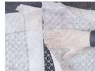
Проклейте место стыка геотекстильных полотен двусторонним скотчем или двусторонней лентой-герметиком.
