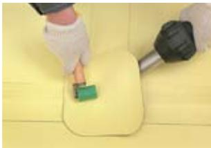
**ВАЖНО!** Перед установкой усиливающей заплатки завальцуйте край мембраны латунным роликом, подогревая поверхность мембраны ручным аппаратом.
