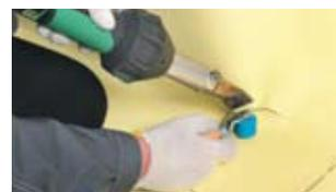
Тщательно проварите остальную площадь заготовки. Используйте широкий силиконовый ролик.
