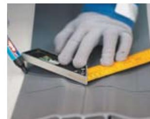
Обрежьте заготовку в соответствии с нанесенной разметкой.
