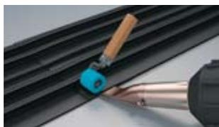
Ведите фен поперек гидрошпонки вдоль сварного шва.
