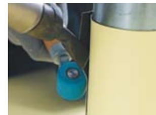
Сварку нахлеста осуществляйте в два захода, чтобы проварить нахлест равномерно по всей ширине. Вначале проварите нахлест из глубины, затем по краю.
