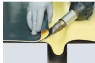
Для этого подготовьте полосу усиления из материала LOGICBASE V-SL, ширина которого должна «покрывать» расстояние от оси шва в обе стороны по **500 мм**. Разместите подготовленную полосу в области шва и точно «прихватите» ее по одному краю для удобства дальнейшей работы.
