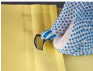
Заварите проверочный канал используя узкую насадку и латунный ролик.
