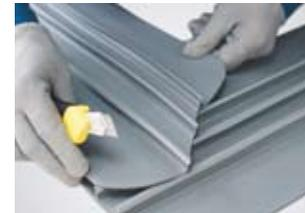
Разметьте, а затем подрежьте ребра гидрошпонки под углом  $45^\circ$ .
