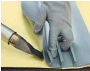
Затем при помощи прикаточного ролика и ручного сварочного аппарата герметично приварите край шпонки.
