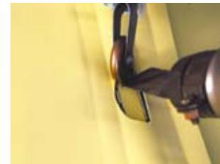
После того как проверочный канал «заглушен» посредством сварки, удалите непроваренную часть нахлеста для последующей установки заплатки.
