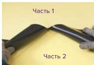
Совместите край разреза первой части с нанесенной разметкой второй части элемента, формируя при этом нахлест для сварки.
