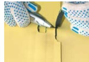
Установите заплатку таким образом, чтобы она «перекрывала» ширину шва и полученное в результате разреза отверстие в проверочном канале. Приварку заплатки начинайте от проверочного канала, двигаясь к ее краям.
