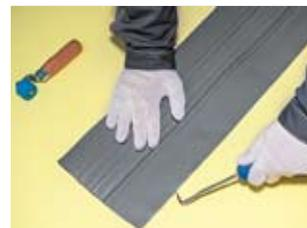
Непрерывно ведите аппарат вдоль шва, равномерно прогревая обе поверхности.
