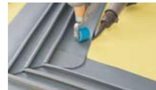
Приварите верхнюю часть нахлеста к поверхности гидроизоляционной мембраны, используя тефлоновый ролик.
