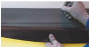
Вместо заранее установленной гидрошпонки **ЕС-220-3** или **ЕС-320-4** для герметичного окончания гидроизоляционной мембраны может быть применена **ПВХ лента**
