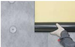
По мере раскатки мембраны приварите ее к ронделям, которыми предварительно был закреплен первый слой геотекстиля.
