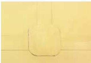
После того как сварной шов остынет, проверьте шов на герметичность давлением воздуха.
