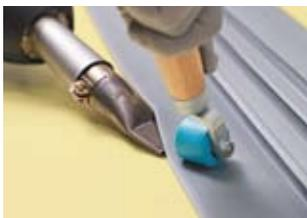
Используйте сварочный автомат «Варимат» для приварки плоского края гидрошпонок к мембране, если протяжённость шва большая.
