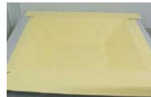
Подготовьте полосы мембраны такой длины, которая необходима для покрытия разреза мембраны с заходом на горизонтальную поверхность.
