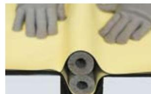
Приварите ее края к основной гидроизоляционной мембране.
