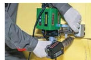
По мере движения аппарата удаляйте временное крепление в виде полос, отрезая их от механического крепления и в области «прихватки».
