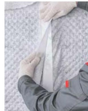
**ВАЖНО!** Скрепление полотен геотекстиля предотвращает заиливание дренажного зазора мембраны.
