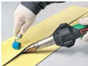
Выдерживая дистанцию в 5–7 мм, прикатывайте ролик параллельно кромке сопла.
