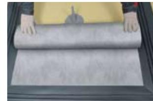
**ВАЖНО!** Не укладывайте геотекстиль на гидрошпонки, их анкера должны быть открыты для последующего бетонирования.
