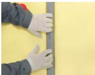
Установите полосу из мембраны **LOGICBASE V-SL**, по ширине превышающую ширину шва на **150–200 мм**, в каждую сторону.
