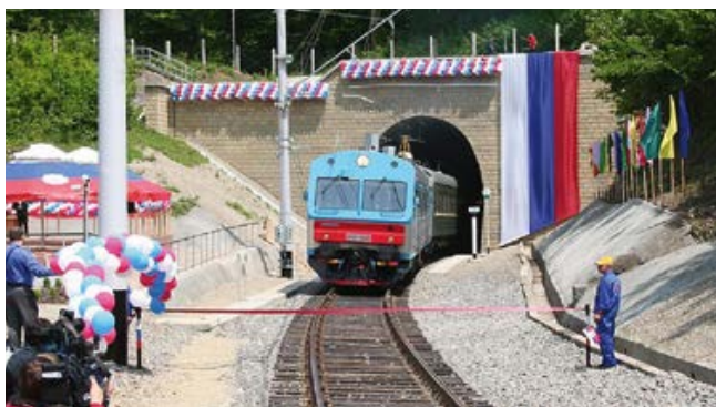
Тоннели участка Армавир–Туапсе Северо-Кавказской железной дороги
