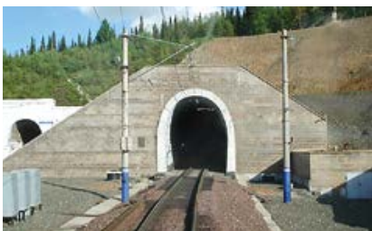
Джебский тоннель, Красноярский край
