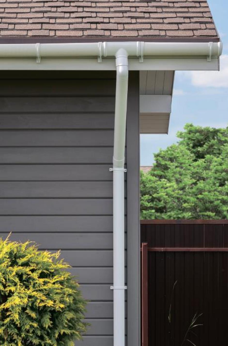
Водосточная система является неотъемлемой частью любого здания. При отсутствии подобного элемента, может возникнуть ряд проблем среди которых можно выделить порчу стен от осадков, намокание фундамента, а также разрушение отмостки и подтопление подвальной части самого здания. Водосточная система является практичной, долговечной, и эстетично смотрится.
